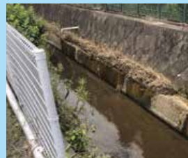
こんな用水路すら氾濫(熊本県)
