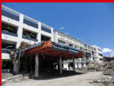
被災した陸前高田市役所
