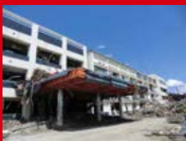
被災した陸前高田市役所
