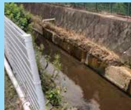
こんな用水路すら氾濫(熊本県)
