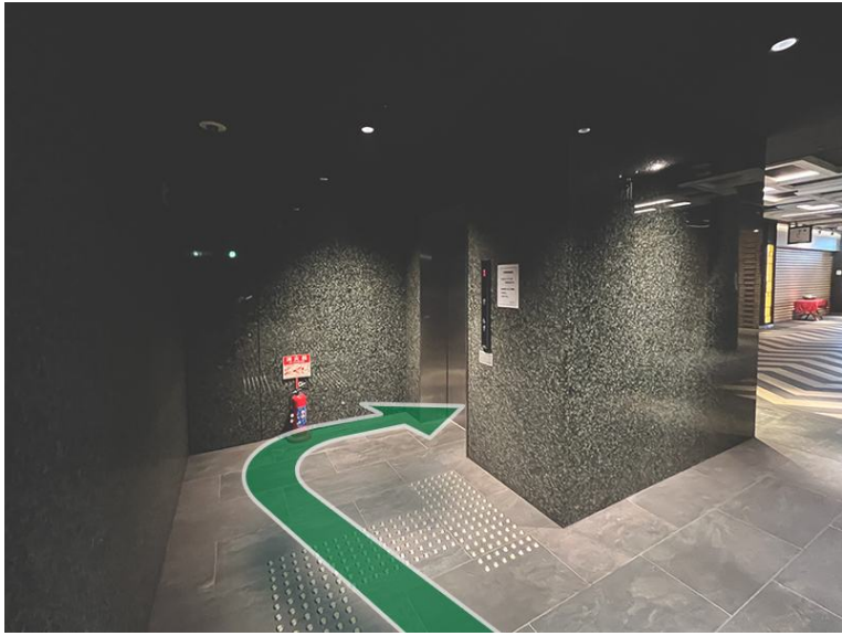
23 「E1エレベーター」に乗り、1階に向かいます。
