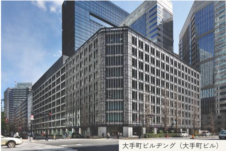
大手町ビルディング（大手町ビル）
