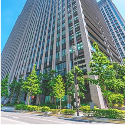
大手町パークビル 駐車場入口
